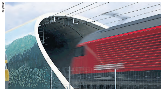
« Les trop nombreux tronçons de ralentissement doivent être rapidement réduits ; des infrastructures de contournement doivent être développées. » Ici un exemple de réalisation de Rail 2000 : l'Emmitunnel, près de Kirchberg (BE).
