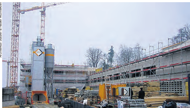
Il tribunale amministrativo federale lascerà nel 2012 la sua sede attuale alla Schwarztorstrasse di Berna per una nuova costruzione a San Gallo. Ciò non impedirà al SEV di farvi capo per difendere i diritti dei suoi membri.
