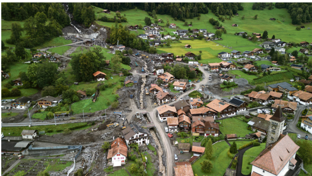
Der westliche Teil von Brienz am 10. September. Die ZB verkehrt hier erst wieder ab November.
