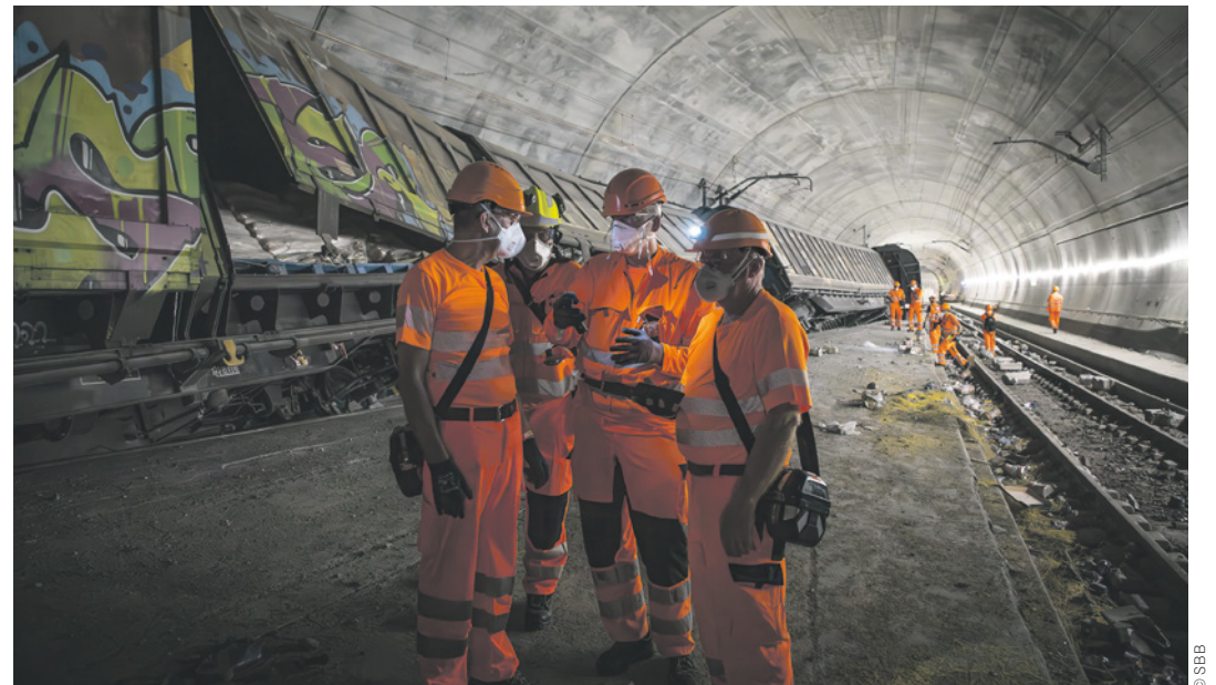
Inspektion nach der Entgleisung im Gotthard-Basistunnel.
