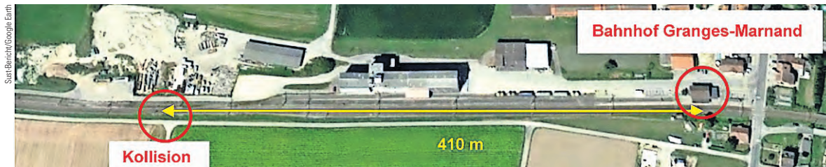
Der Fahrdienstleiter hätte den Unfall verhindern können, wenn er für das Abschalten der Fahrleitung klar instruiert worden wäre.
