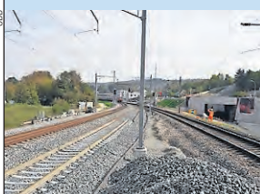
Das neue Gleis ist befahrbar.
